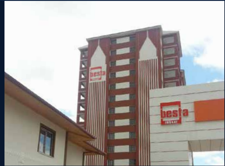
MALATYA - BESTA İNŞAAT EVLERİ
